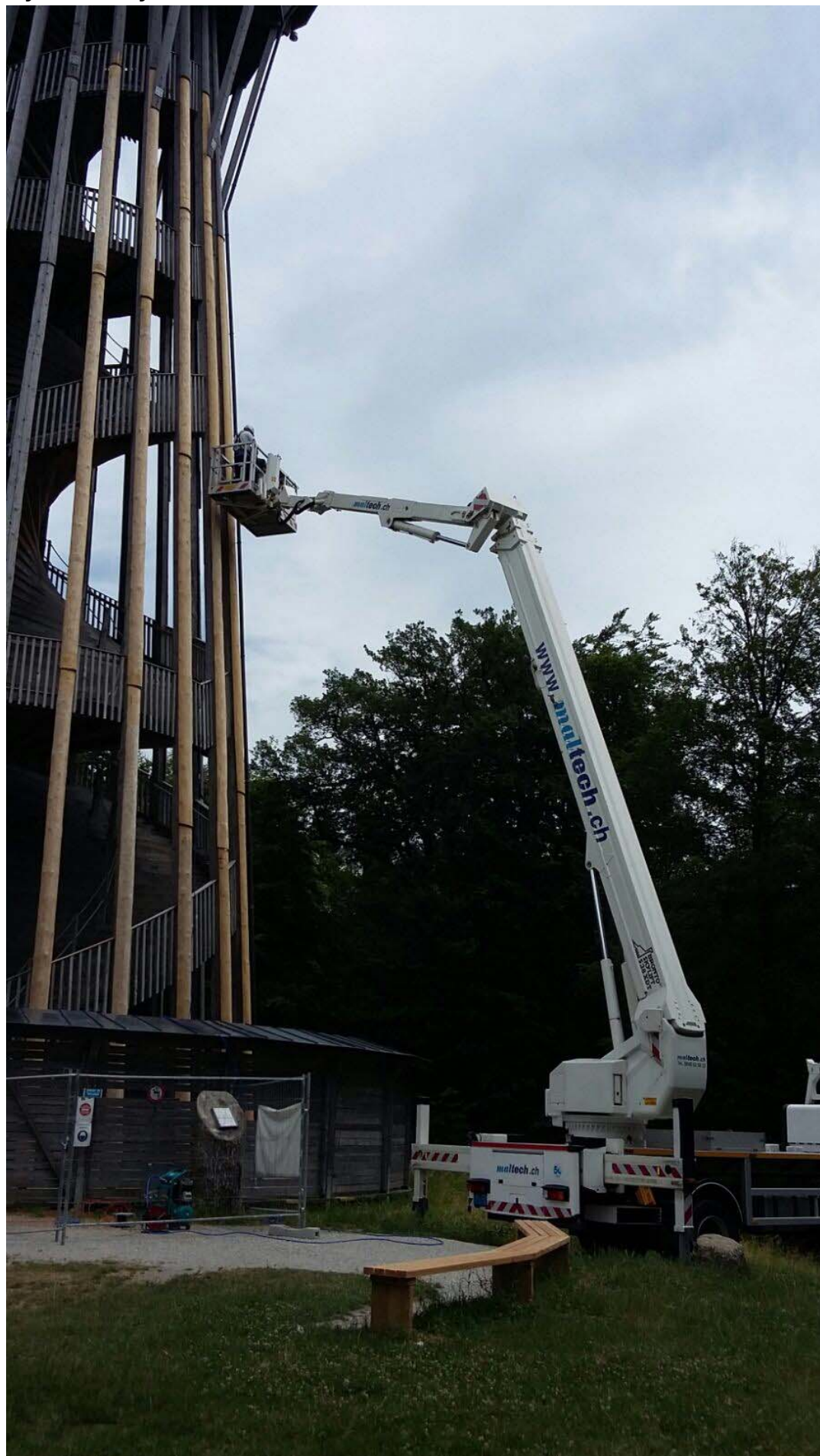
Injection des joints 26.06.17 vue d'ensemble
