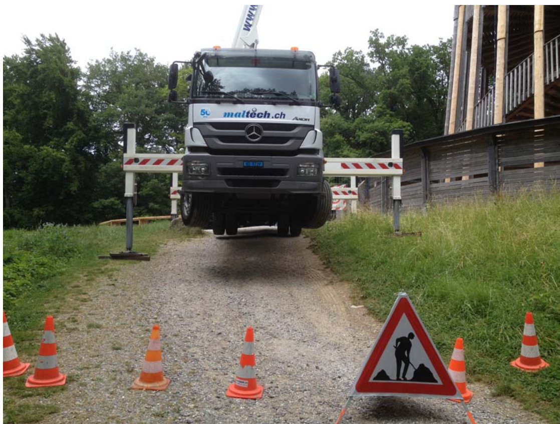
Un camion nacelle qui s'envoie en l'air ... dans une position acrobatique, pour pouvoir injecter les joints verticaux des demi-ronds, réalisés avec des barres de fer à béton de diam 16-600, insérées au préalable lors de la mise en place de ceux-ci
